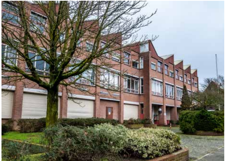
Locatie Vossenlaan 44, waar drie appartementencomplexen gebouwd gaan worden.
