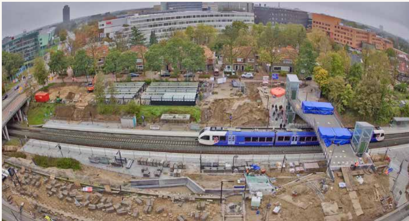
De nieuwe loopbrug over het spoor is ingehangen. Foto: Thea van den Heuvel.
