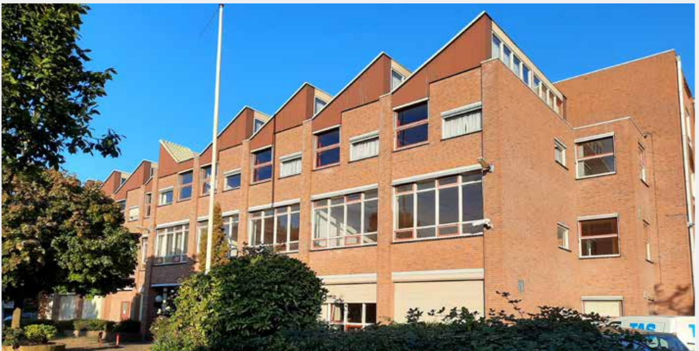
De voormalige ROC-vestiging aan de Vossenlaan 44.
