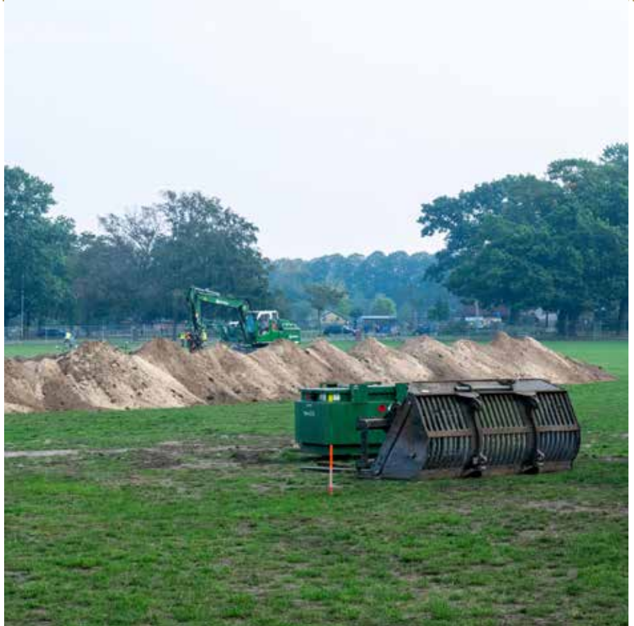
Tot op 2,5 meter diepte wordt gezocht naar gevaarlijke materialen.
